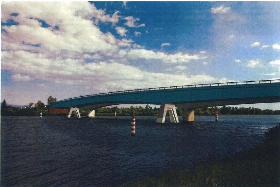
Les poutres de la charpente métallique, à hauteur variable, permettent à l'ouvrage de s'inscrire sur le tracé de l'ouvrage existant.
