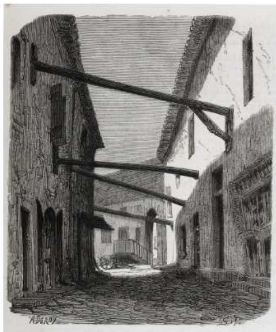
Châteauneuf-du-Rhône : le séisme du 19 juillet 1873 a nécessité la pose d'étais sur quelques maisons de la rue principale (Dessin d'après L'Illustration)
