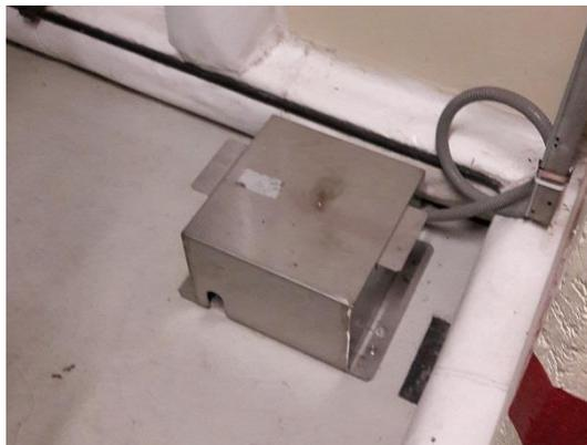
La centrale de Cruas-Meysses dispose de 5 accéléromètres : 3 capteurs au niveau de l'îlot nucléaire construit sur appuis parasismiques (dont 2 en bâtiment réacteur) et de 2 autres capteurs situés en d'autres points de l'installation.
