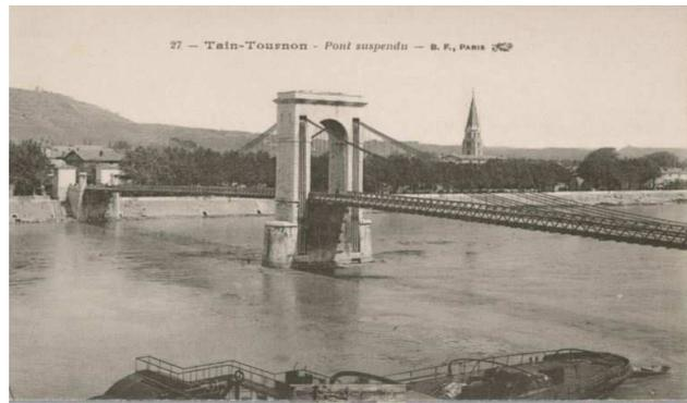
Dès 1848, un second pont suspendu à platelage bois dit "Passerelle Marc Seguin" (celle aujourd'hui transmise par les deux Départements aux deux communes), fût construit légèrement en aval du premier pont et utilisé par les piétons principalement.
