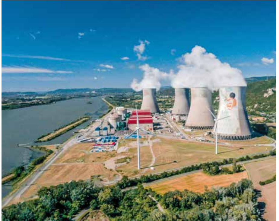
Centrale nucléaire de Cruas-Meysses
