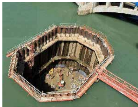
Exemple de batardeau
