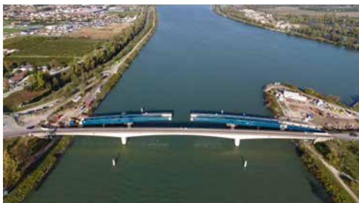
Lançage de la charpente métallique - ©Vinci construction
