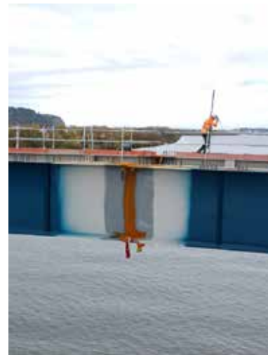
23 novembre 2022 - Lançage de la charpente métallique - ©CD07
