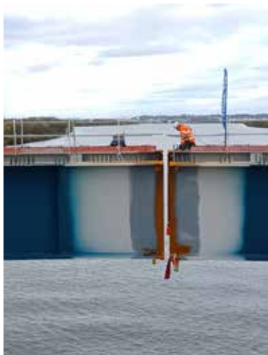
Lançage de la charpente métallique - ©Vinci construction
