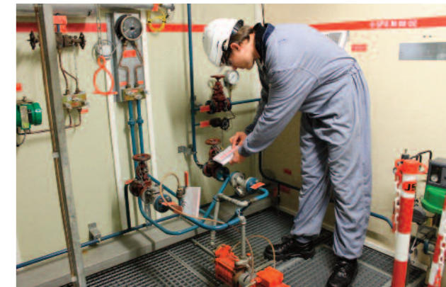
Le chantier école ouvert le 5 novembre 2014
