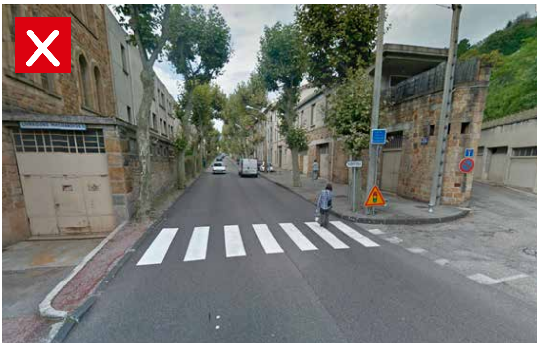
Passage piéton non accessible, absence de cheminement latéral.
