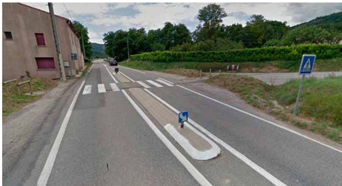
Îlot refuge, éclairage, 70. Hors agglomération N4
