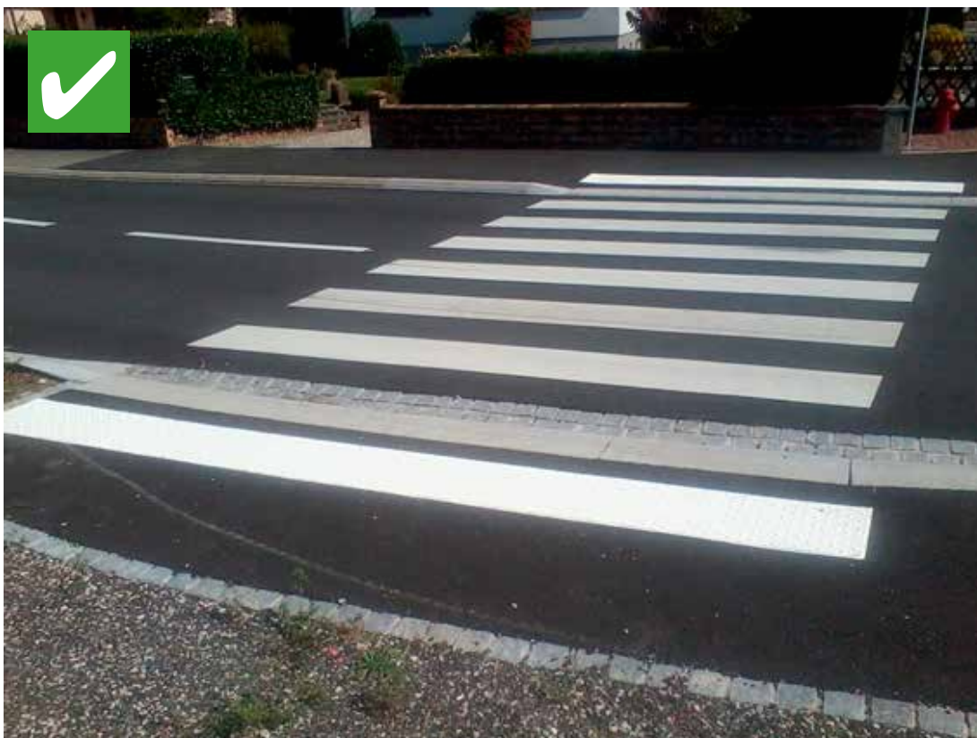
Passage piéton accessible, entre cheminements latéraux.
