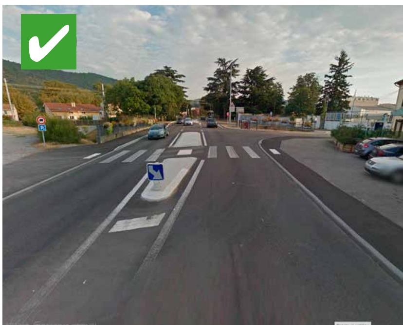
Passage piéton sur îlot refuge.
