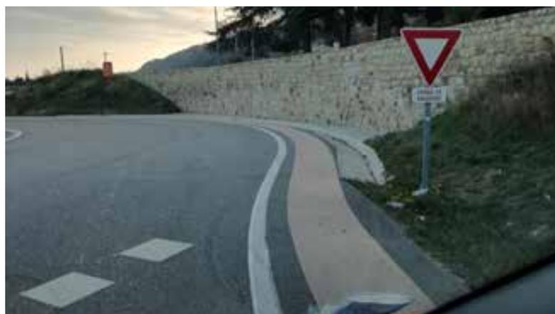
**Les fins de surlargeurs** devront être accompagnées afin de ne pas mettre le cycliste dans une situation de danger et pour renforcer la vigilance de l'automobiliste (mise en œuvre de zébras...).
