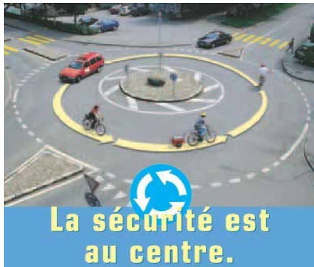
**Pour des raisons de sécurité, aucun marquage au sol ne sera appliqué dans les giratoires** (risques de glissance pour les cyclistes et les motards en cas de pluie). En revanche, il est possible **d'agir sur le rayon de l'îlot central** franchissable du giratoire. Elargir ce dernier permet aux automobilistes de moins couper la trajectoire et donc d'adopter des vitesses plus faibles en entrée de giratoires.
