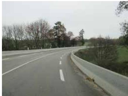
**Les surlargeurs** sont créés uniquement dans le cadre d'opérations de réfection de chaussée, afin d'assurer une meilleure qualité (pas de joint, pas de risque d'affaissement...).
