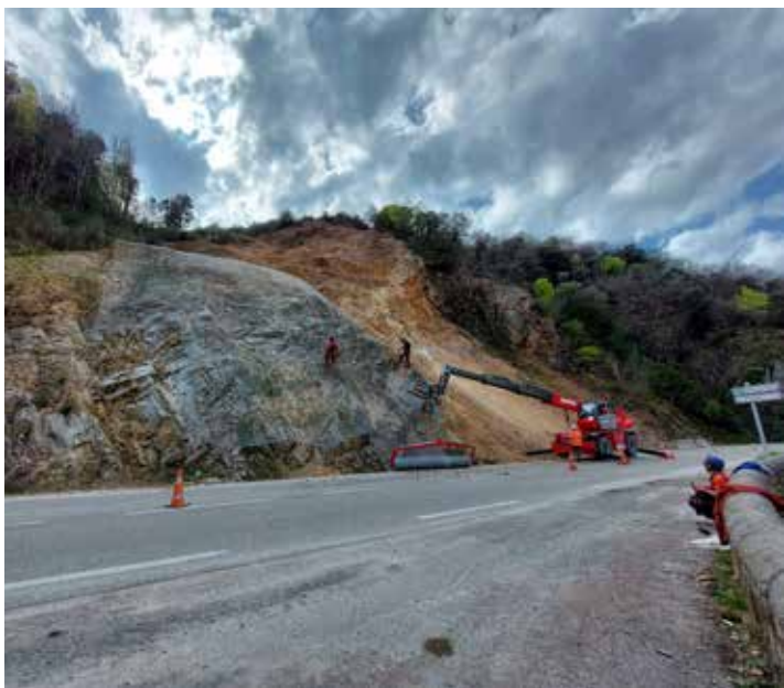
En 2023, le Département consacre plus de 18 M€ à la réhabilitation des routes départementales garantissant aux Ardéchois le bon état du patrimoine routier et leur sécurité au travers de divers chantiers menés sur le territoire à l'instar des travaux acrobatiques réalisés pour la sécurisation de la falaise sur la RD 120 au Pont de Chervil à Beauvène en avril dernier.
