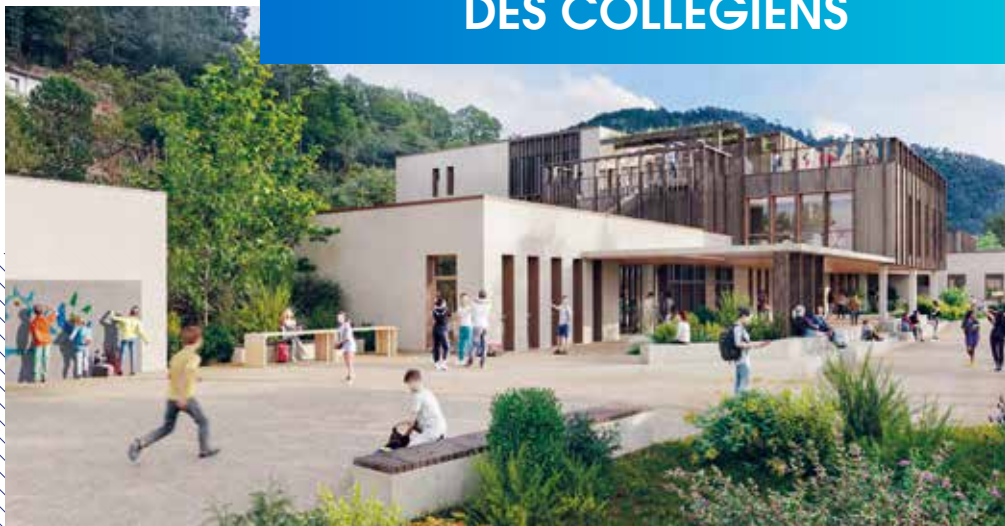
Le collège de Saint-Sauveur-de-Montagut, après travaux.
