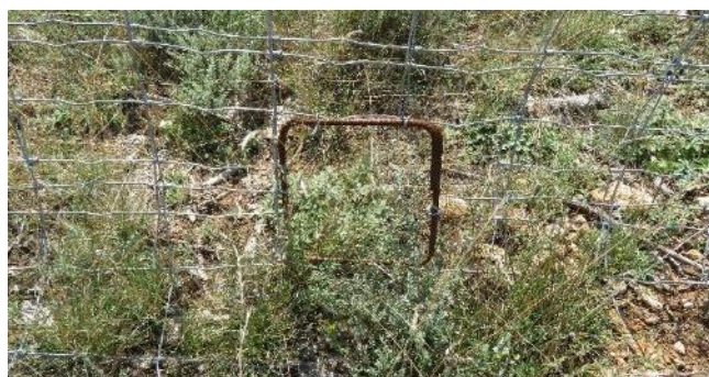
Trouée avec cadre en fer à béton au sein d'une clôture pour permettre ici, le passage uniquement de la petite faune. Source : ECOTER
